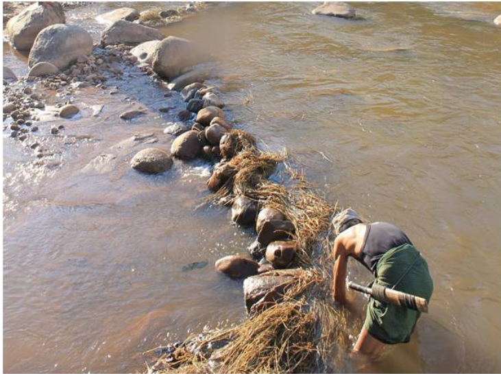
รูปที่ ๖ การยกน้ำด้วยหินและฟางข้าว เพื่อปรับแต่งอ่างน้ำ
